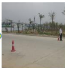
特气房外路段人员管制
