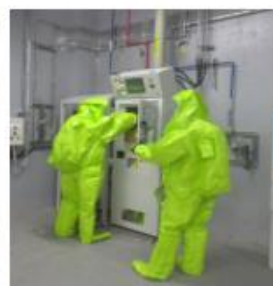
关闭阀门 确认排风正常
